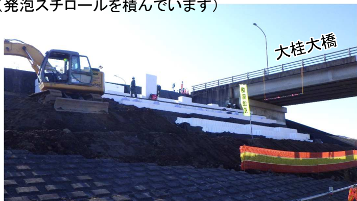
施工状況 (発泡スチロールを積んでいます)
